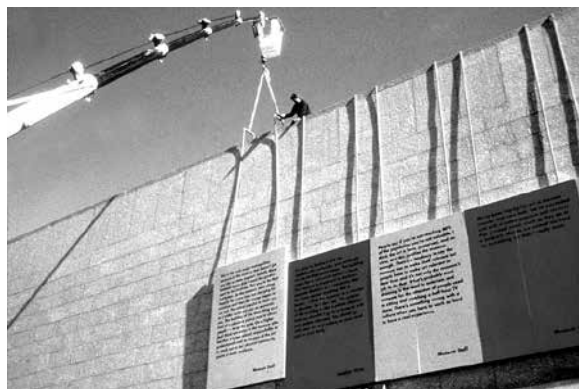
3a-b. Group material, installation des panneaux de Democracy Wall , à l'occasion de In and Out of Place , à Boston, Museum of Fine Arts, 19 octobre 1993 – 23 janvier 1994.
