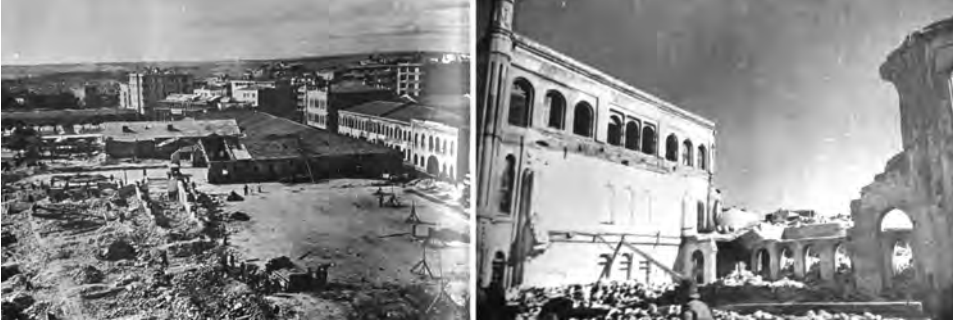
Şekil 3: Taksim Kışlası'nın ahırları yıkılıyor (sağda), Kışla yıkılıyor (solda). (Gülersoy, 1986:83,97)
